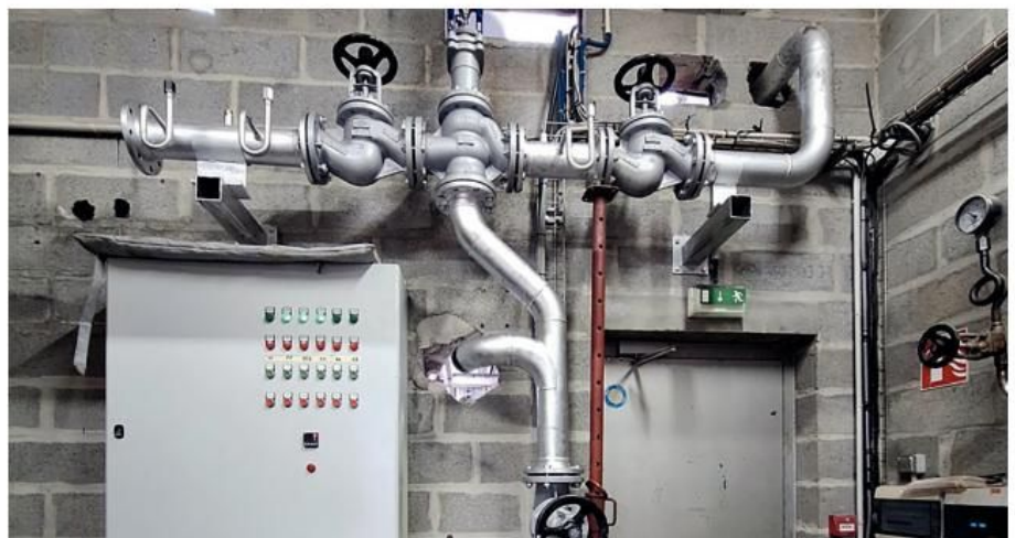
Intégration de la récupération au niveau chaudière.
